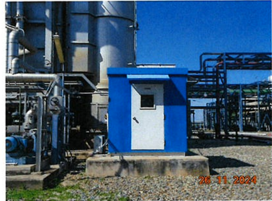
ภาพที่ 2.2-2 ระบบ CEMS ของปล่อง HRSG#11
