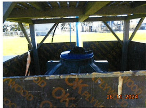
ภาพที่ 2.1-8 ระบบบำบัดน้ำเสียสำเร็จรูปจากห้องน้ำห้องส้วม
