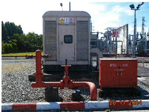
หัวฉีดน้ำดับเพลิง (Fire Hydrant)
