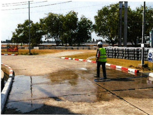
ภาพที่ 2.1-1 การฉีดพรมน้ำบริเวณพื้นที่ก่อสร้างและถนนภายในโครงการ
