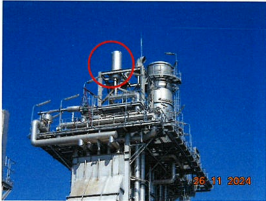
ภาพที่ 2.2-7 Silencer ที่ Safety Valve
