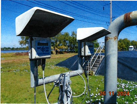
ภาพที่ 2.2-19 pH Online และ Conductivity Online บริเวณบ่อกักน้ำทิ้ง
