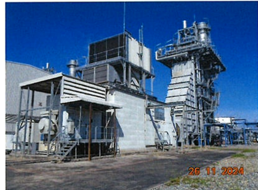
ภาพที่ 2.2-6 ห้องครอบเครื่องจักร บริเวณห้องเผาไหม้ของเครื่องกังหันก๊าซ
