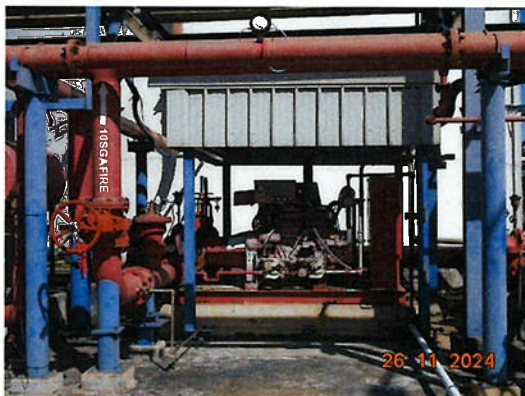
ภาพที่ 2.2-60 เครื่องสูบน้ำดับเพลิงหลัก
