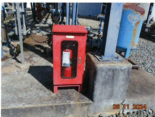
ถังดับเพลิงแบบมือถือ ชนิดผงเคมีแห้ง
