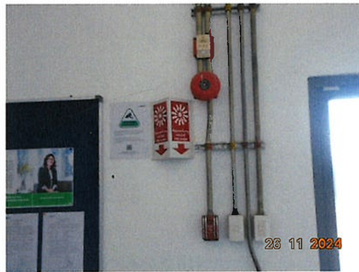
ภาพที่ 2.2-57 สัญญาณแจ้งเตือนเหตุเพลิงไหม้ (Fire Alarm)
