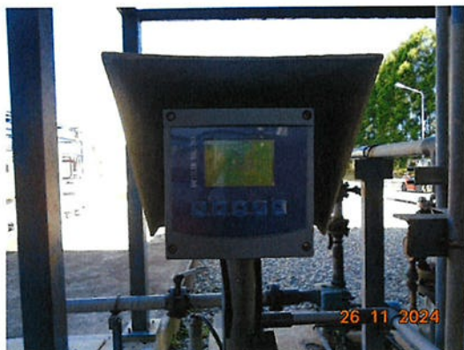
ภาพที่ 2.2-17 pH Online บริเวณบ่อปรับสภาพน้ำ (Neutralization Pit)
