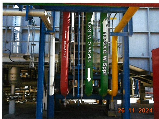
ภาพที่ 2.2-50 ระบบการทาสีและเครื่องหมาย ตัวอักษร แสดงทิศทางการไหลของระบบท่อและ อุปกรณ์ต่างๆ
