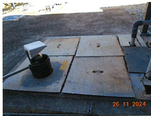
ภาพที่ 2.2-16 บ่อปรับสภาพน้ำ (Neutralization Pit)
