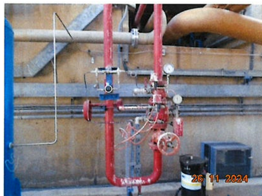
ภาพที่ 2.2-63 Fire Water Spray System บริเวณ Steam Turbine Generator Bearing Area
